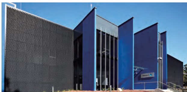
Intellicentre 2(オーストラリア、シドニー)
